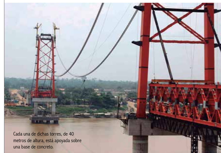
El puente Aguaytía, sobre el río del mismo nombre. Tiene 576.4 metros de largo (340 metros de una orilla a la otra) y una distancia de 200 metros entre sus dos torres
