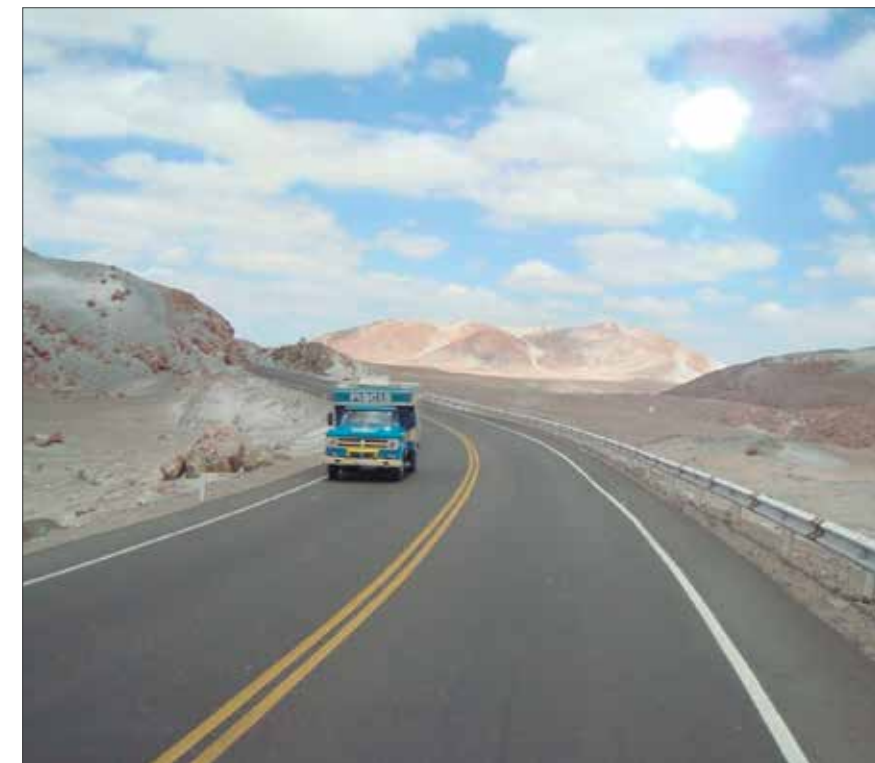
Tramo 5 de la IRSA Sur. La carretera permite una integración interna para el desarrollo de los siguientes departamentos: Madre de Dios, Cusco, Puno, Arequipa, Moquegua, Tacna, Apurímac, Ayacucho, Huancavelica e Ica.
