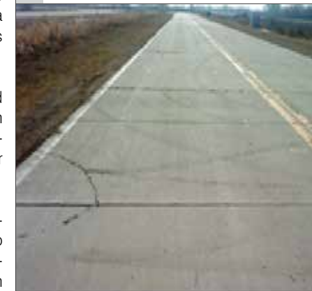
Figura 5.a Fisuras por Fatiga
