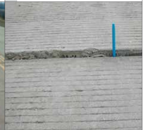
Figura 5.b Desnivel entre las losas
