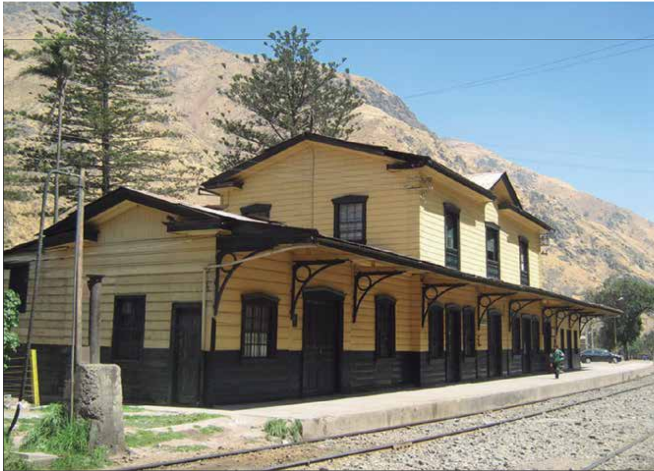
Estación de "Matucana" que actualmente no funciona ni se le da mantenimiento.
