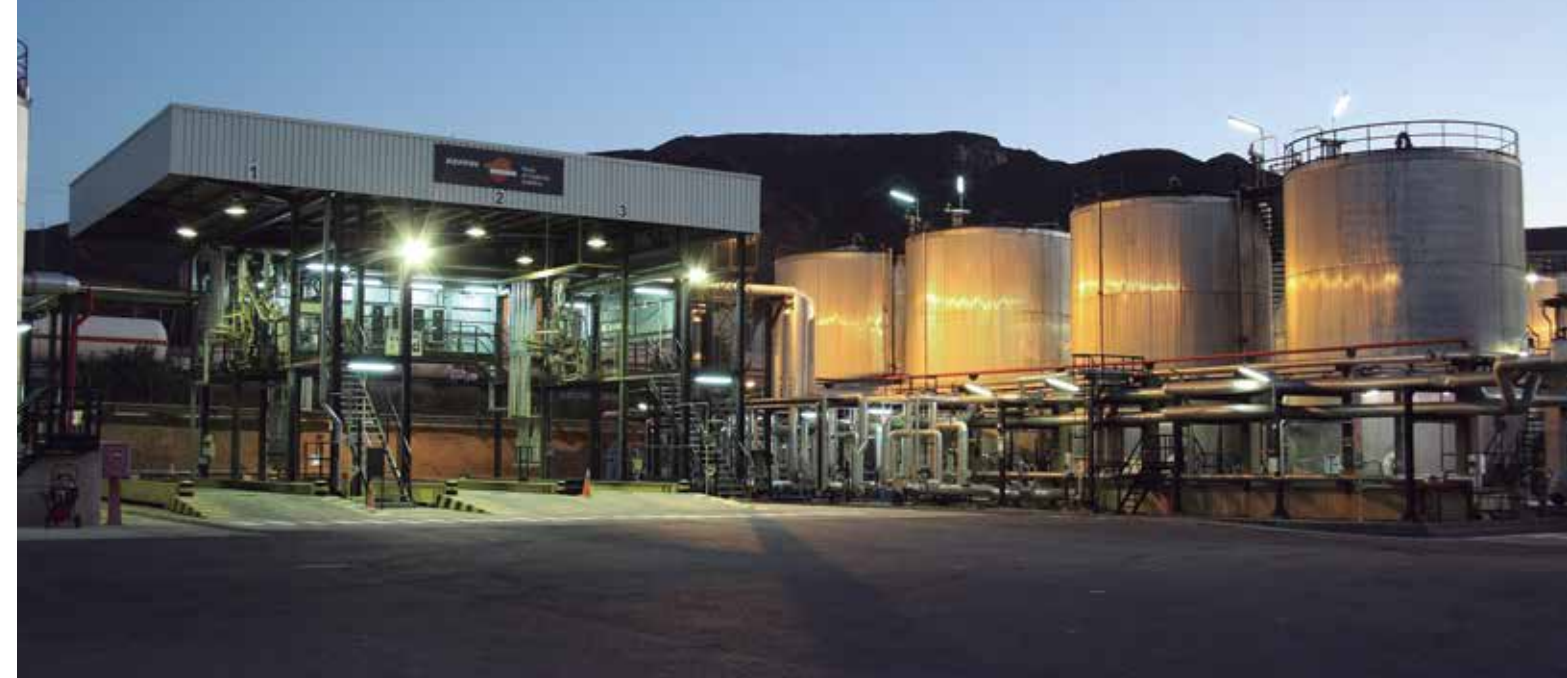
Moderna planta de blendeo y despacho de asfaltos (Cartagena-España, 2010).
