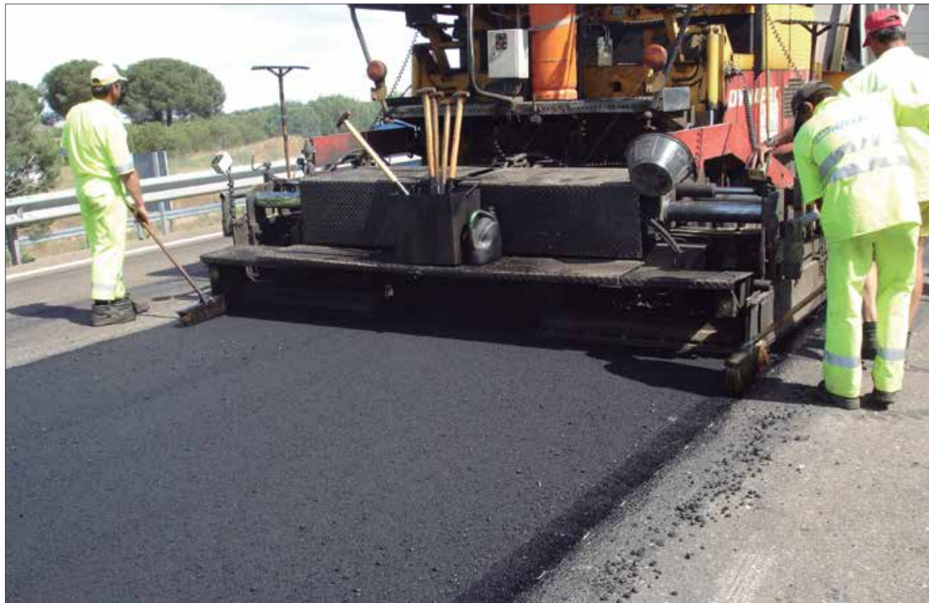
Mezcla con caucho reciclado (asphalt rubber).
