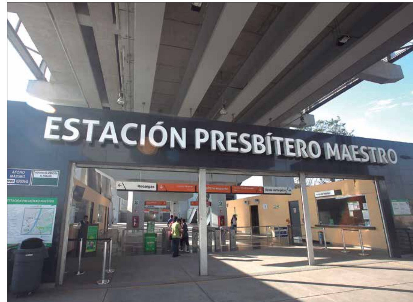
↑ Estación del Presbítero Maestro que pertenece a la segunda etapa de la línea 1. Esta etapa se puso en funcionamiento a mediados del 2014.
