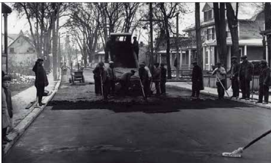
▲ Pavimentación de calles con mástico de asfalto natural. Francia.
