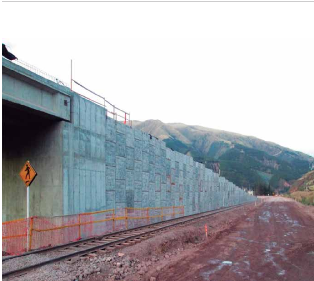
▲ Rampa de acceso al puente con muro de suelo reforzado back to back culminado.
