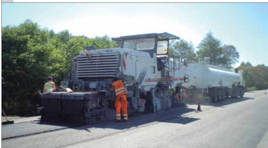
▲ Reciclado de pavimento en frío con emulsión.
