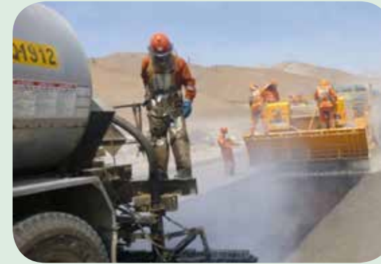
RIEGO DE ASFALTO MODIFICADO
