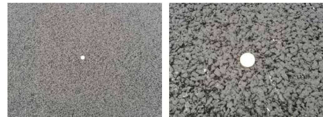
FIGURA 15: ASPECTO DE LA MEZCLA SMA8 UNA VEZ EXTENDIDA (UTRERA)
