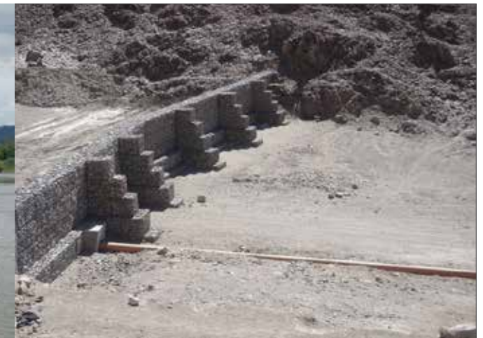
▲ Dique de Contención – Perú.
