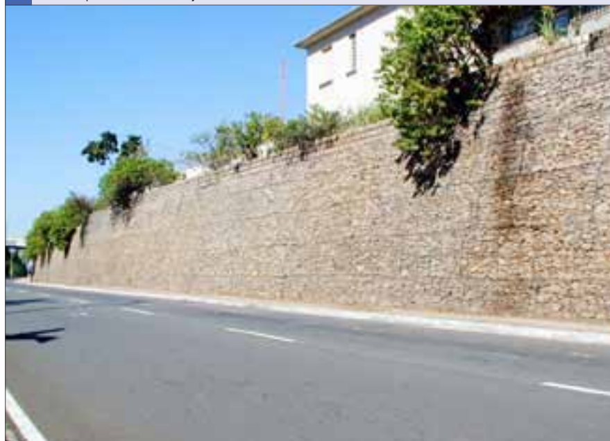
▲ Muro de Contención a gravedad empleando Gaviones.
