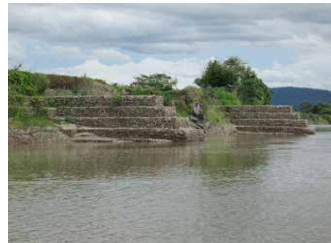
▲ Espigones y defensa ribereña empleando Gaviones – Villa Toscana, San Martín - Perú.
