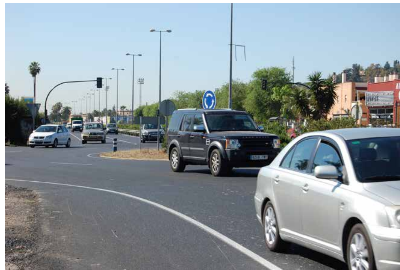
FIGURA 8: ASPECTO DEL TRÁFICO QUE CIRCULA POR EL FIRME SONO-REDUCTOR DE LA CARRETERA A-8058
