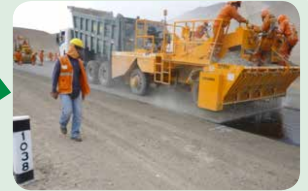
APLICACIÓN DEL AGREGADO
