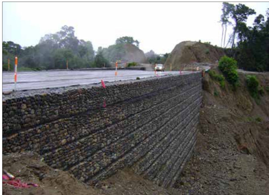
▲ Muro empleando Terramesh System – Carretera Interoceánica Sur Km. 703, Perú – Brasil.
