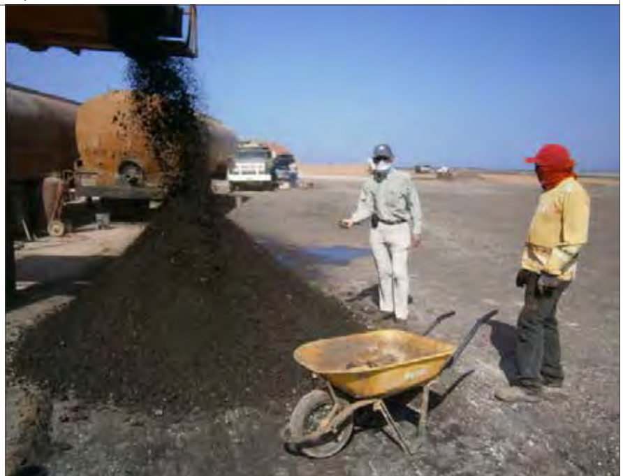
Figura 6 Proceso final de producción de mezcla.
