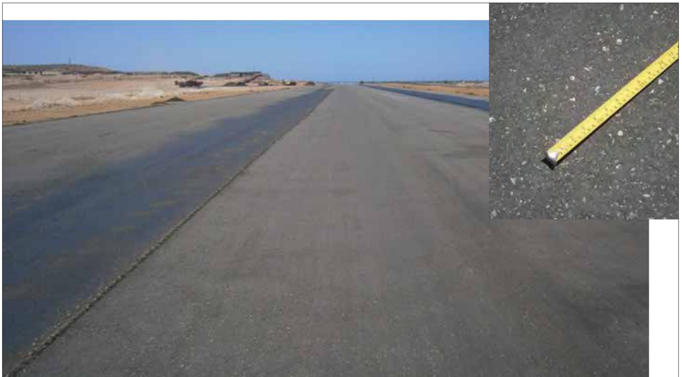
Figura 10. Vista de la capa asfáltica de la pista y detalle superficial.
