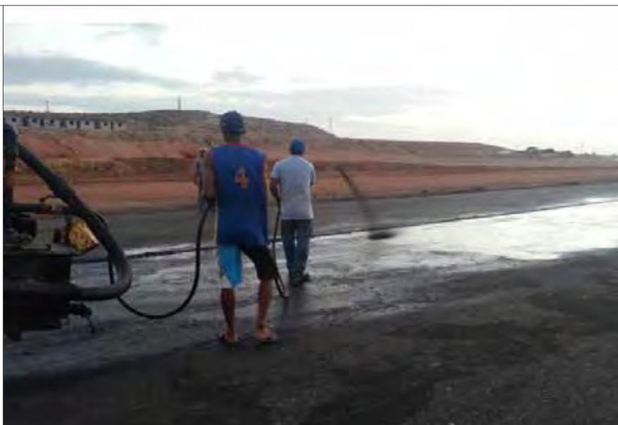
Figura 7. Aplicación de riego sobre pavimento original, saneado.
