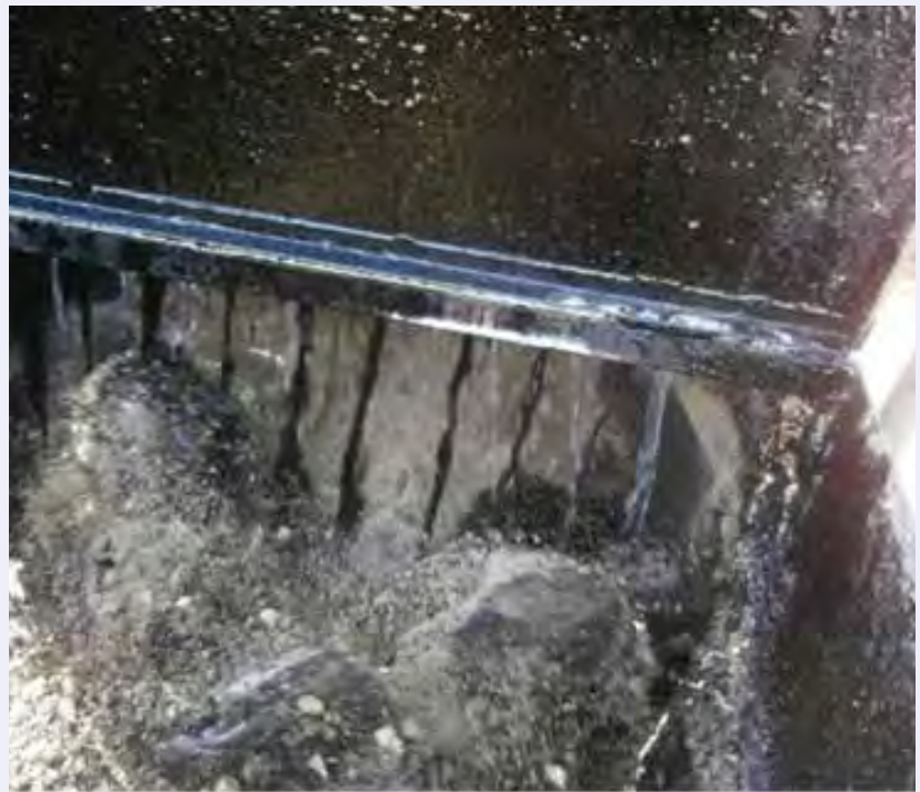
Caja de mezclado: adición de agua y EA
