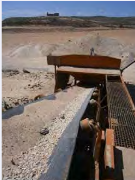
Alimentación de agregados: 70% arena local, 30% agregado triturado (arrocillo) transportado
