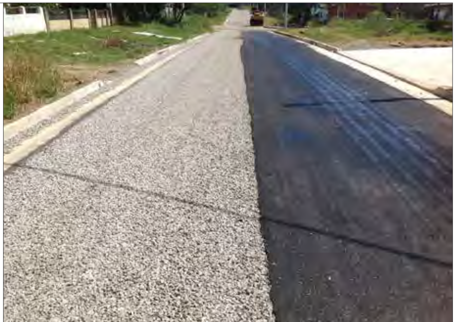
Figura 4: Agua en superficie por compactación neumática.
