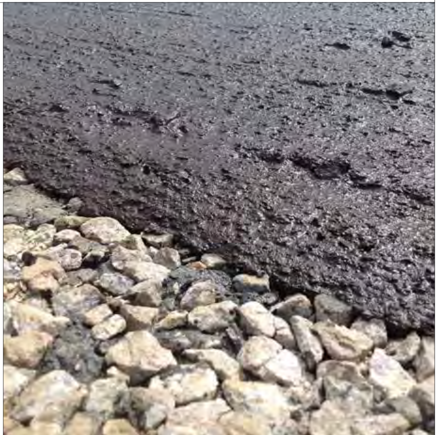
Figura 3: Espesor del microaglomerado en frío.
