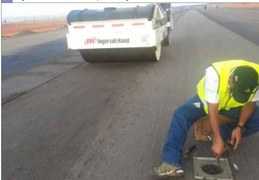
Figura 9. Compactación y control de la segunda capa.
