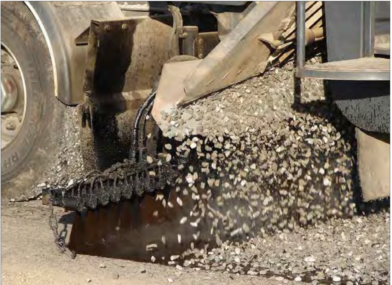
Figura 2: Doble esparcidora aplicando el tratamiento bituminoso.
