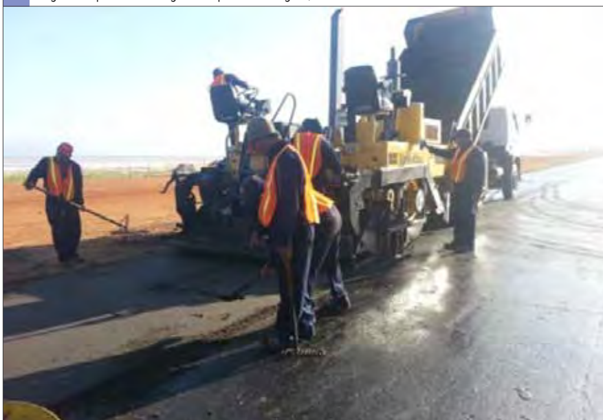
Figura 8. Extendido de mezcla sobre pavimento original.
