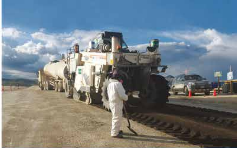
▶ Suelos estabilizados con emulsiones
