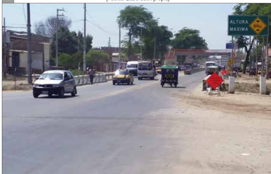
Figura N° 06. Puente La Primavera, Piura, Perú. (Fuente: información propia)
