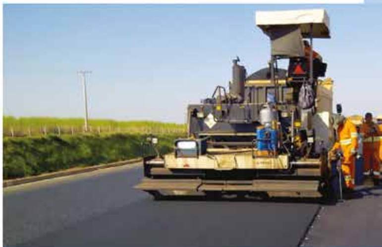
▶ Mezclas asfálticas en caliente
