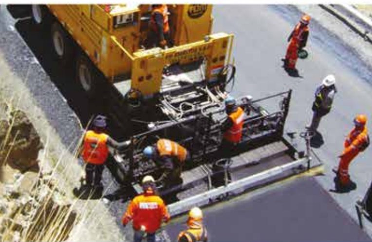
▶ Aplicación de micropavimento
