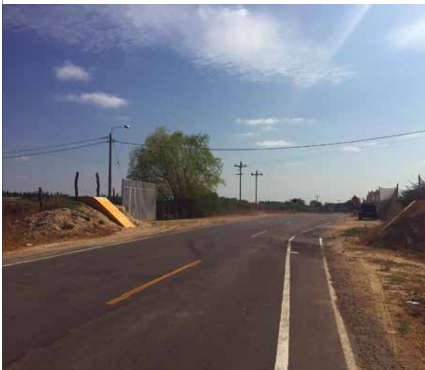
Figura N° 07. (a) Proyecto entregado y puesto en servicio y (b) sección corregida. (Fuente: (a) Facebook, (b) información propia)
