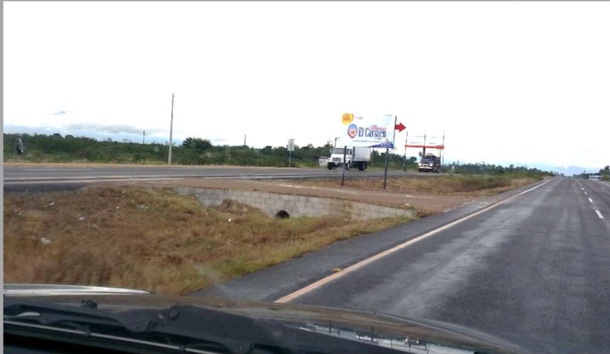
Cruce informal, muy peligroso.
