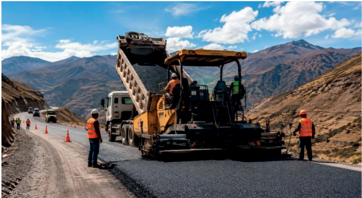
Figura 1. La adherencia entre capas comienza antes de la compactación: preservar la uniformidad del riego de liga hasta la colocación de la mezcla asfáltica es fundamental para el desempeño de la interfaz.
