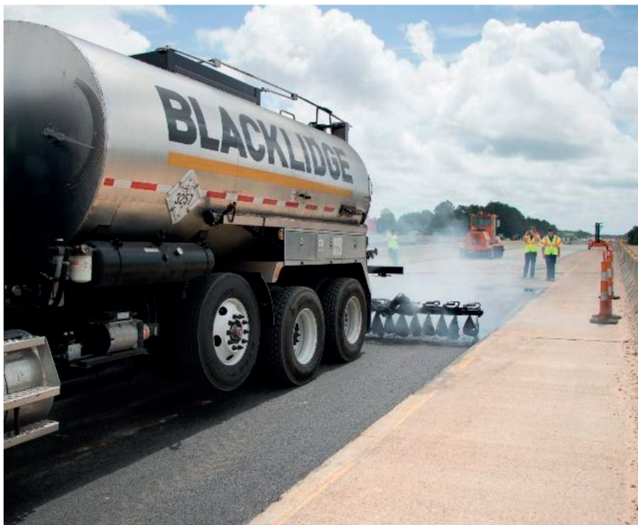
Figura 4. Aplicación de un riego de liga tipo trackless. Estas tecnologías han sido desarrolladas para reducir el levantamiento del ligante por los neumáticos durante las operaciones de construcción, preservando la película necesaria para la posterior adherencia entre capas. Fuente: Blacklidge Emulsions.
